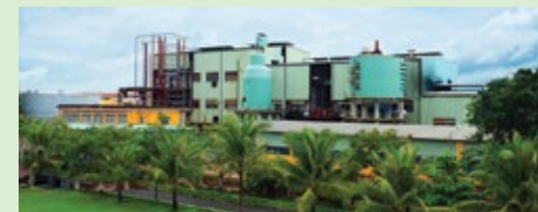
Nhà máy TTCS Gia Lai
